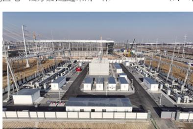
化舱式设备、单元式辅助用房、预制式构筑物、智能二次设备防误系统等,物联边缘管理平台等多项新技术,助力变电站建设提质增效。(陶涛)
