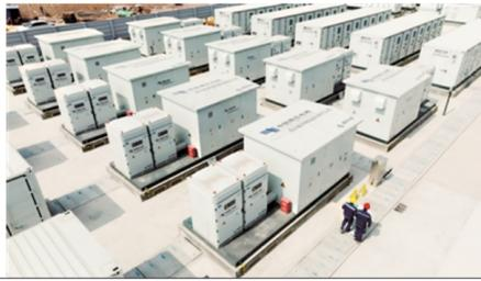
5.2兆瓦时,能够实现电池运行温升不超过5摄氏度,不同电池温差不超过2摄氏度。”项目从开工建设到试运行仅用了4个多月时间,电站的设备采用预制舱式的结构,系统主要设备均放置在集装箱中,现场进行组装即可开展调试,进一步缩短建设周期,提升安全建设水平。(俞昭君)
