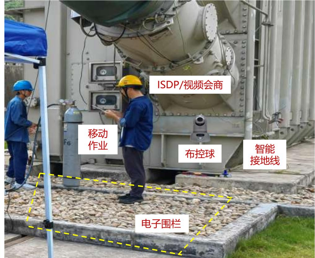
人员定位+电子围栏实现越界识别，ISDP实现作业现场管控、远程专家协作，智能接地线等智能化器具实现工器具的智能管理；在站内作业的整个流程，对人员安全进行管控。
