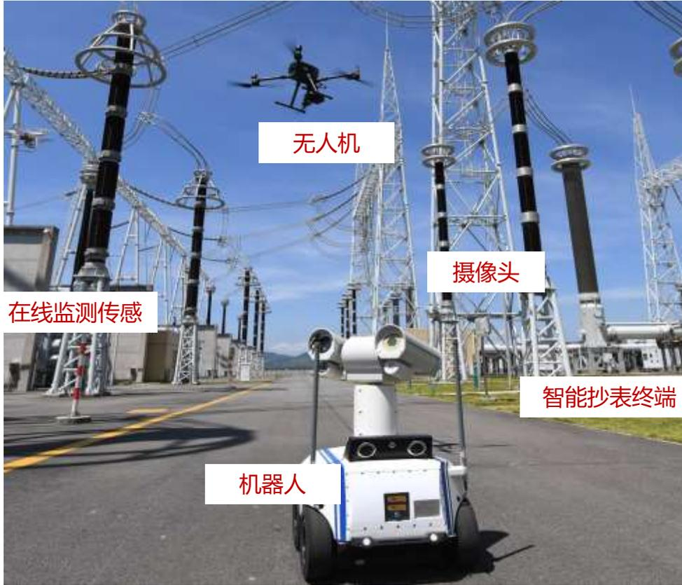
利用机器人、无人机、摄像头、智能抄表终端、在线监测等智能设备，完成巡视任务、数据采集、数据分析、结果上报全过程的工作，实现无人化的智能巡检。
