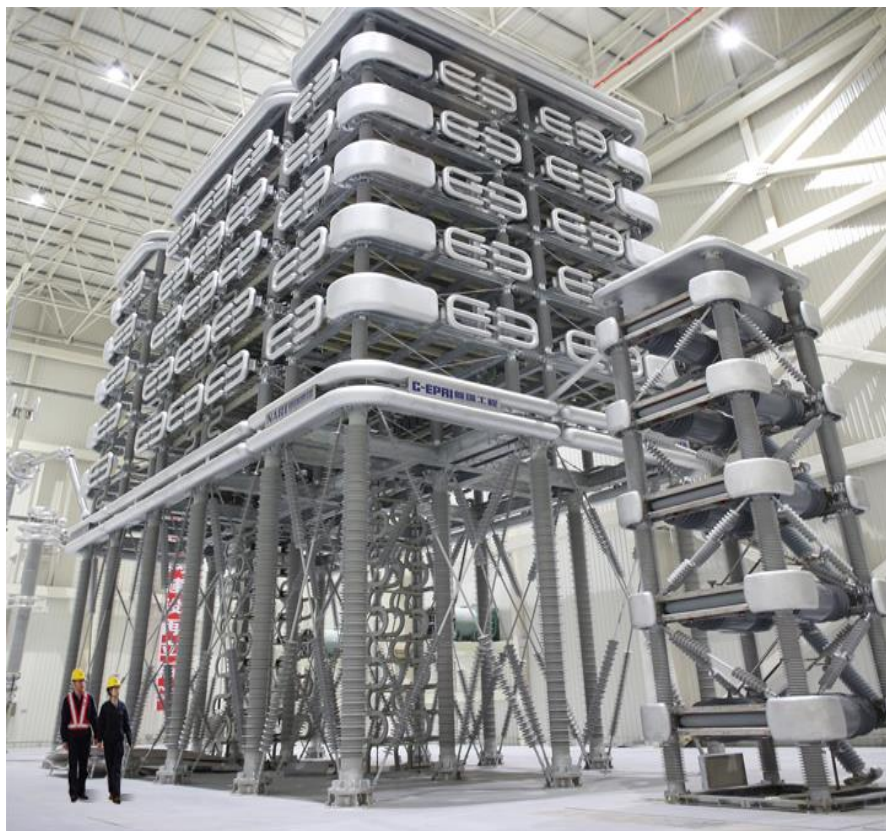
张北500kV/3ms/25kA混合式直流断路器
