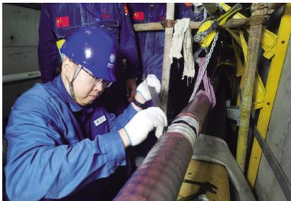
良好电气连接,阻止烧蚀进一步发生的电缆修复手段。通过本次试点作业,填补了全国缓冲层烧蚀双注液修复技术“零”的空白,避免了更换电缆造成的资源浪费,修复成本较比更换电缆成本降低80%。(王成全)
