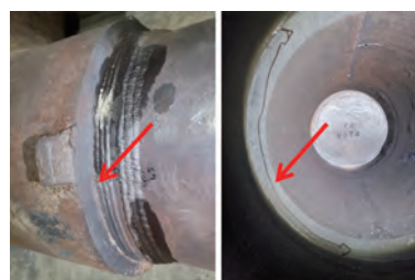
a) 外壁 b) 内壁
