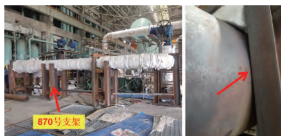
图6 临时管道870号支架
