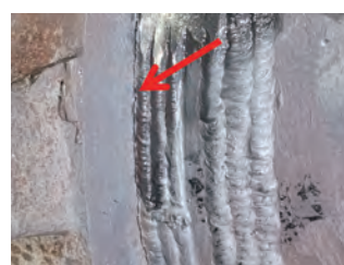
图4 外壁裂纹局部形貌
