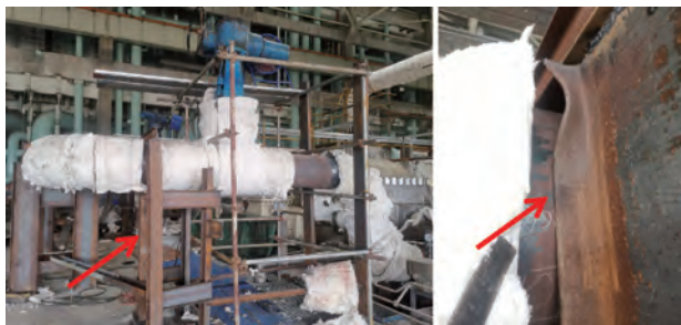
图7 右侧临冲门前支架
