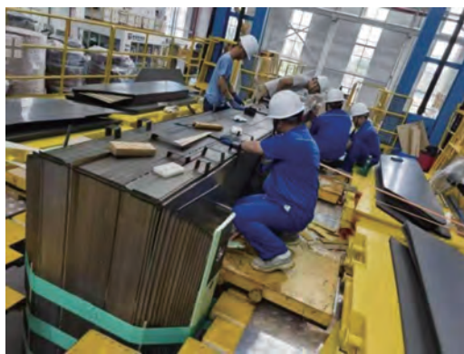
图7 受损铁芯硅钢片更换
