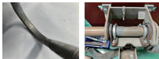
图18 扁平抱箍固定方式
