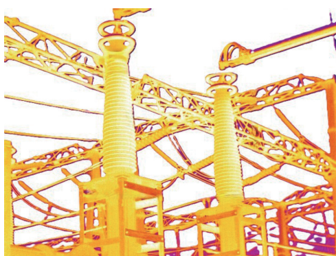
图3 电力设备及母线构架的3DGS重建结果
