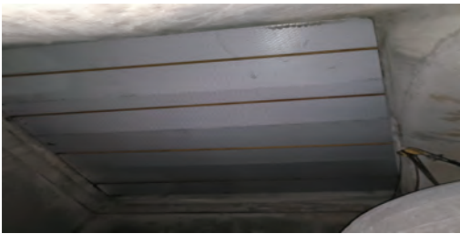
图3 入口烟道挡流钢板已安装完成
